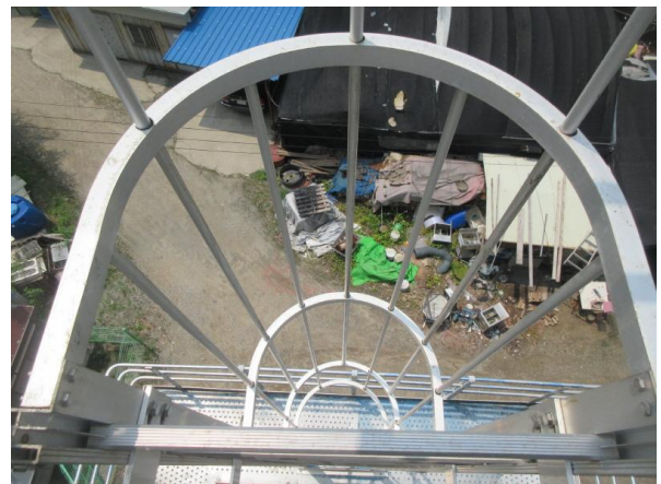
점검사다리 상태양호 P2
